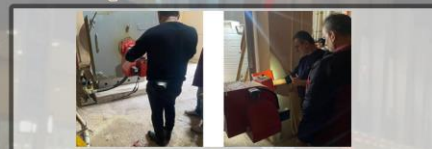
تعمیر مشعل موتور خانه جهت راه اندازی آب گرم سرویس های بهداشتی
