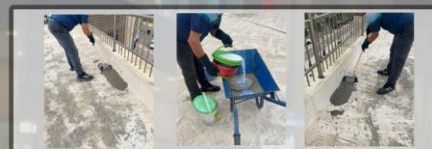
عایق کاری درز های پشت بام با مواد مخصوص برای رفع ریزش آب
